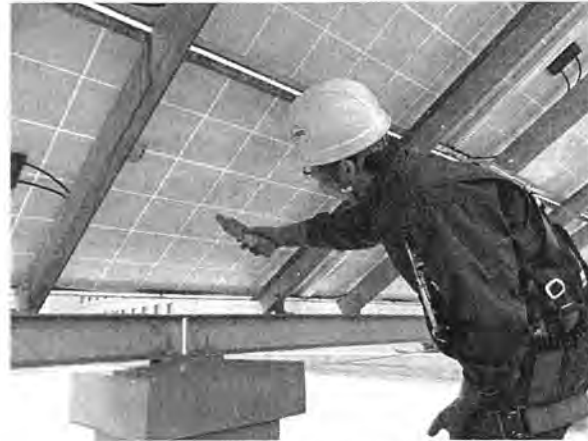
(d) モジュール裏側からの探査
