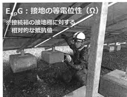
(c) 接続箱の接地極と各モジュールのフレームとの間の抵抗値の測定
