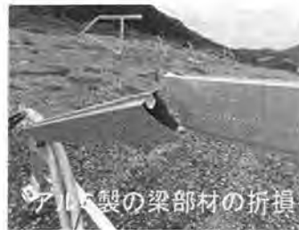
第1図 台風によるPVSの飛散事故例(2015年8月、福岡県)(写真提供:被害者)
